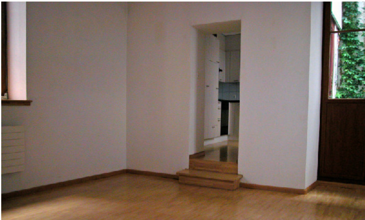
Hölzerne Schwelle. Gerbergässlein 30, 4051 Basel (1495)
