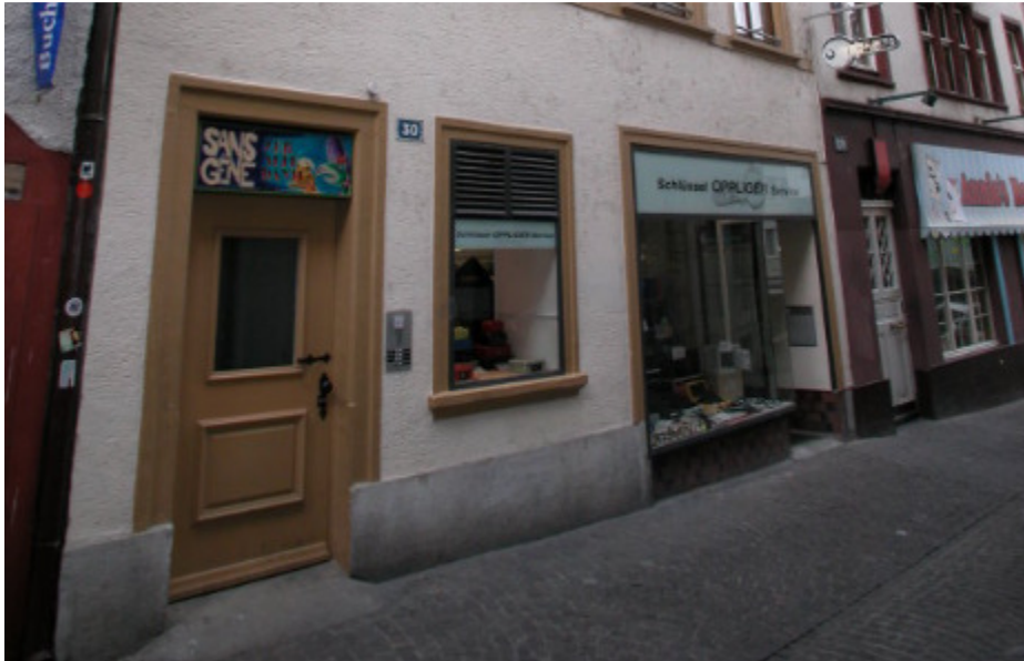
Rampe aus Kopfsteinpflaster. Gerbergässlein 30, 4051 Basel (1495)
