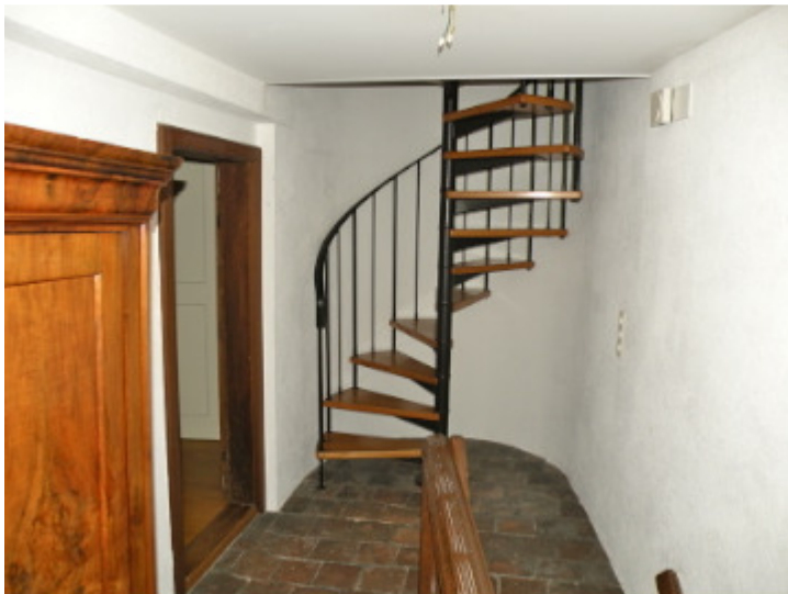
Wendeltreppe (Holztritte u. Metallgeländer). Leonhardsberg 15, 4051 Basel (1842)
