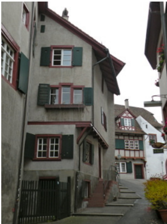
Vorkragung (Ständerkonstruktion). Leonhardsberg 15, 4051 Basel
